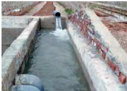
شکل ۴- طراحی انتقال آب از حوضچه رسوب گیر به استخر اصلی با لوله های زانویی شکل برای انتقال آب زیر سطح (آب پایین) و نگه داشتن و جدا کردن روغن که روی سطح آب باقی می ماند.
