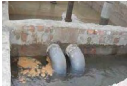
شکل ۴- طراحی انتقال آب از حوضچه رسوب گیر به استخر اصلی با لوله های زانویی شکل برای انتقال آب زیر سطح (آب پایین) و نگه داشتن و جدا کردن روغن که روی سطح آب باقی می ماند.
