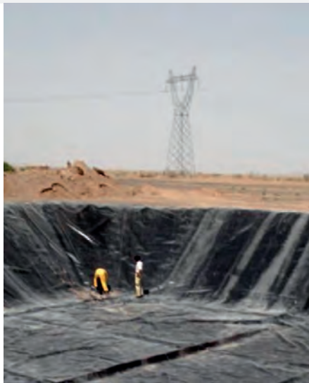
شکل ۲- مراحل ساخت استخر با پوشش پلی اتیلن
