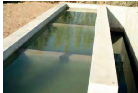
شکل ۳- طراحی حوضچه های پلکانی قبل از ورود آب به استخر اصلی برای رسوب ذرات شن و ماسه و مواد معلق سنگین تر از آب
