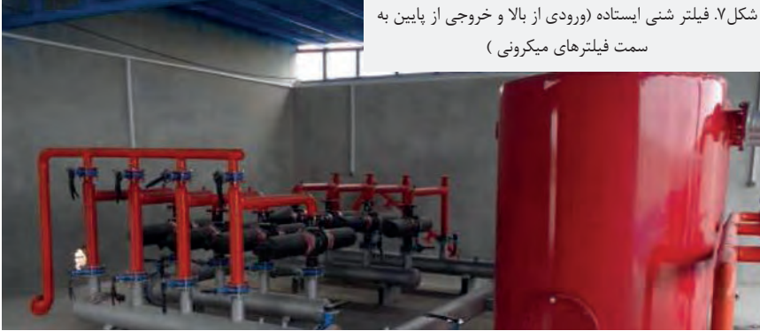
شکل ۸- فیلترهای دیسکی دو قلو بر روی کلکتور ها
