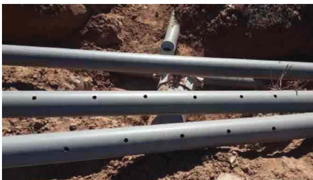
عکس ۴- لوله های بکار رفته در روش آبیاری با لوله های مشبک زیرزمینی
