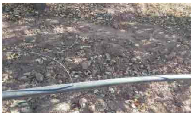
عکس ۲- نمونه لوله های جانبی ۳۲ میلیمتری و لوله های ماکارونی که روی آن نصب شده و عمل قطره چکان را انجام می دهد
