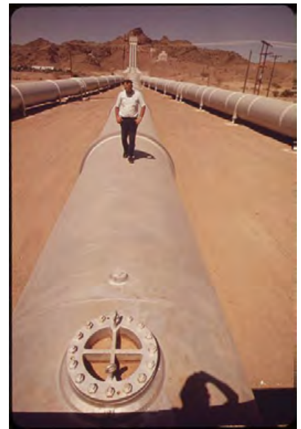
لوله های کانال آب کالیفرنیا. منبع ویکی پدیا
