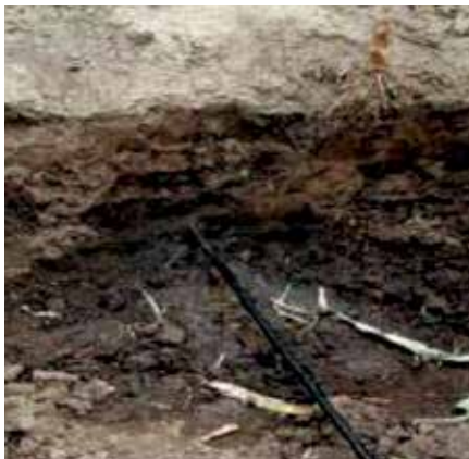
شکل ۱. خط لوله نصب شده در زیر خاک
